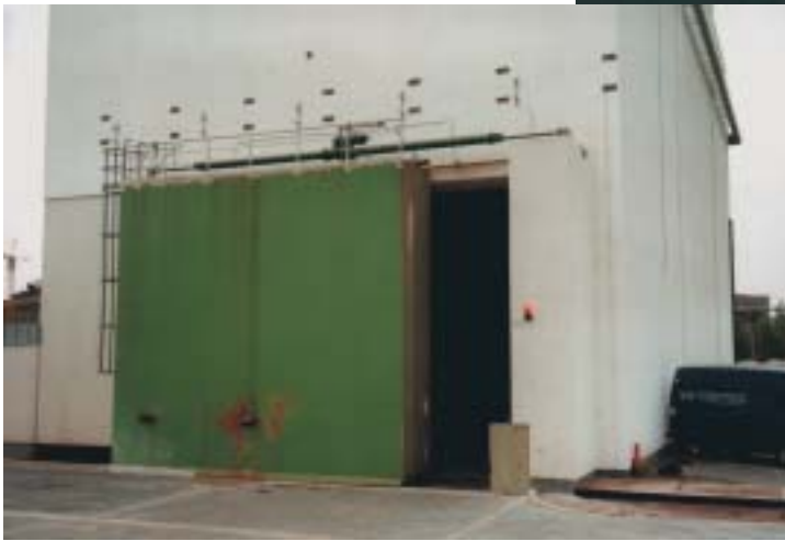
Torverstellung Kraft: 10 t, Hub: 7000 mm
