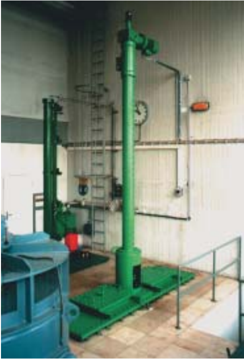
Schützenantrieb Schleusenanlage
