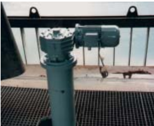
Schützenantrieb Wuppervorsperre
